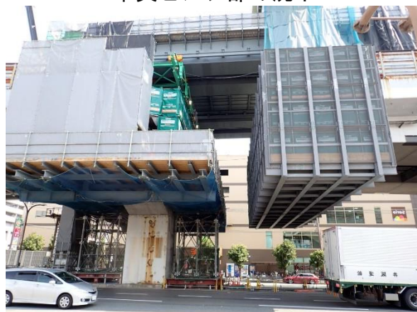
既設桁撤去状況
