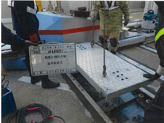
車両重量計設備定期点検
