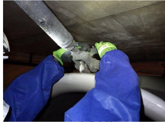
トンネル換気設備定期点検
