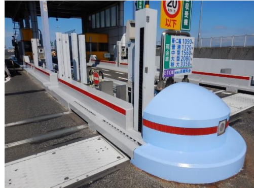
料金所アイランド損傷（補修後）
