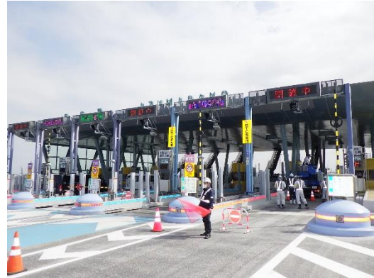
料金所の点検実施状況
