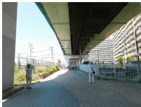
日常点検（路下）
