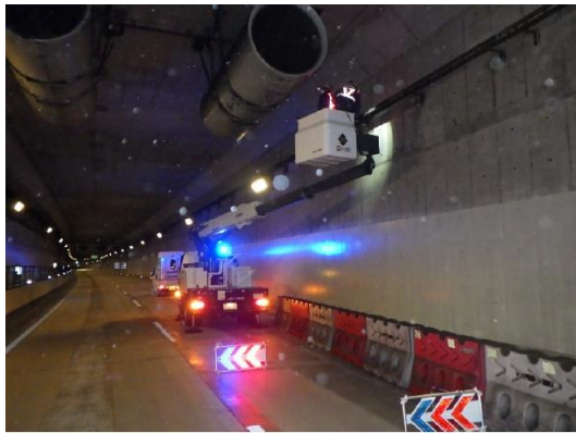
トンネル換気設備定期点検
