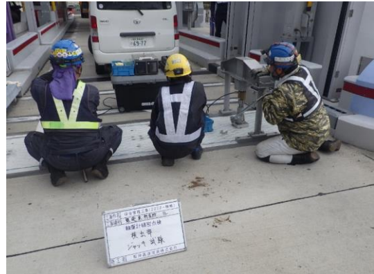
車両重量計設備定期点検
