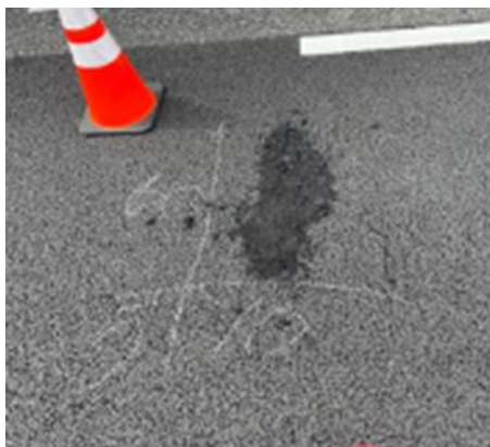
ポットホールの緊急対応の様子
