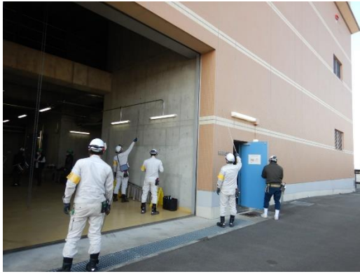
建物の点検実施状況
