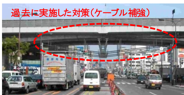
従来のケーブル補強状況
