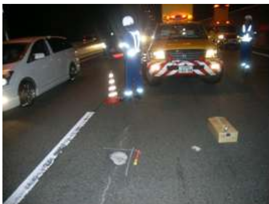
ポットホールの緊急対応の様子
