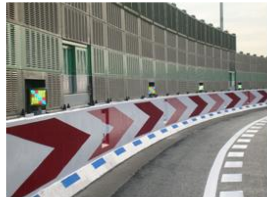
朝潮橋カーブでの安全対策
